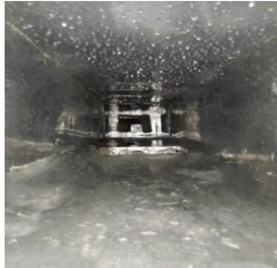
主楼 1 楼西厨房管道清洗后 2
