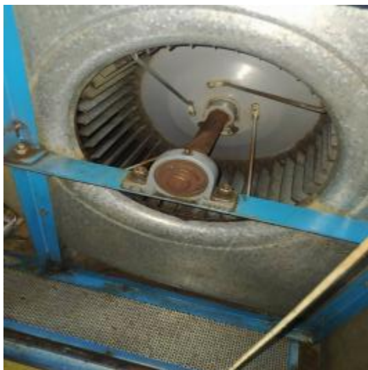
东楼1楼厨房风机清洗前
