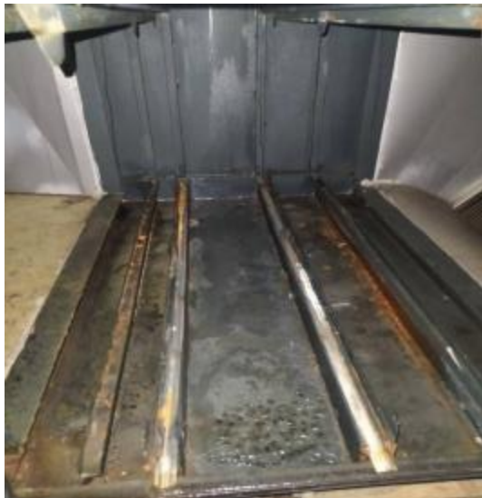
东楼1楼净化器机箱清洗前
