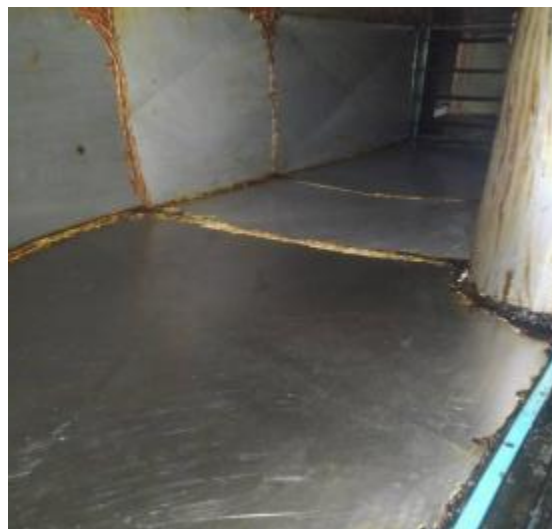
东楼横管道清洗后
