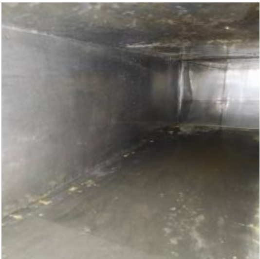
主楼3楼厨房管道清洗后
