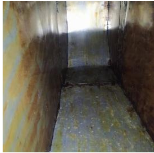
主楼 4 楼库房管道清洗后
