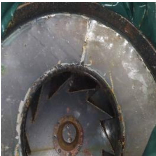
主楼平台风机清洗后 2
