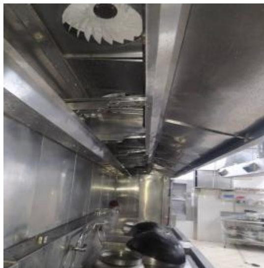
主楼 4 楼厨房烟罩清洗后 1
