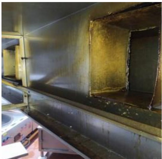
主楼3楼厨房烟罩清洗前 2
