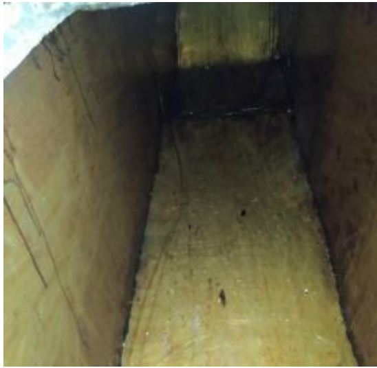
主楼 4 楼库房管道清洗前
