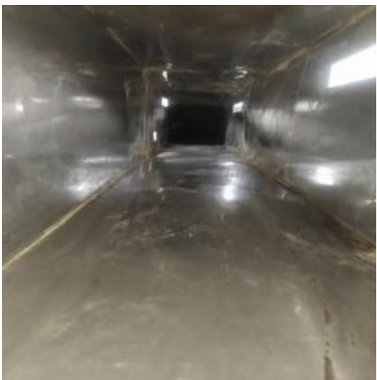
主楼3楼厨房新风管清洗前后
