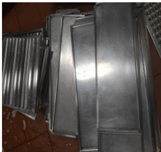
东楼 1 楼防火板清洗后
