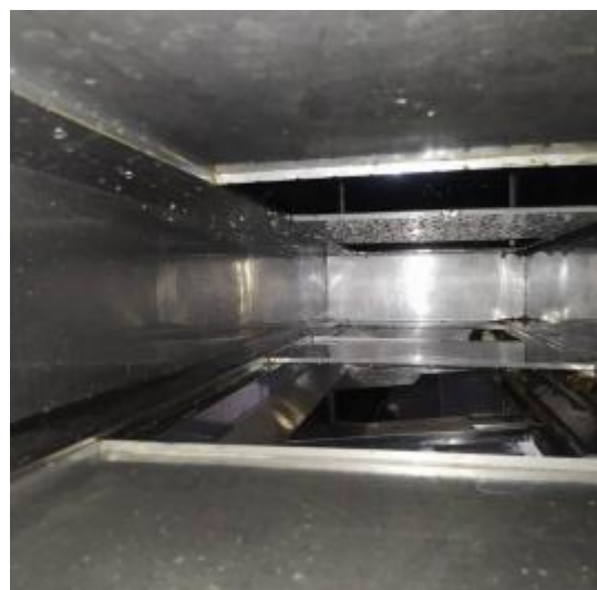
主楼 4 楼厨房管道清洗后 2
