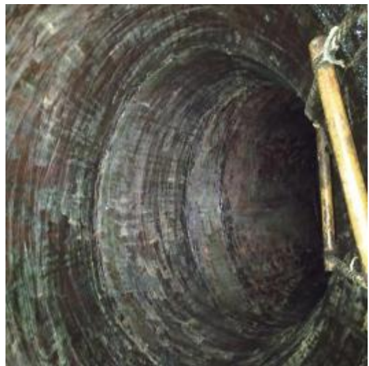
主楼 5 到 4 楼竖管清洗后
