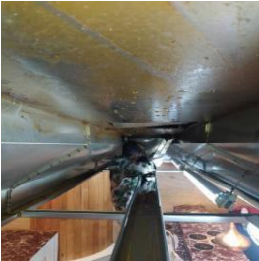
主楼1楼西厨烟罩施工中
