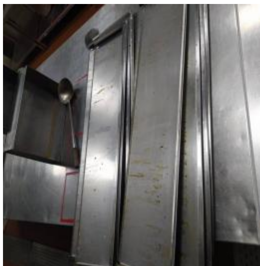
东楼 1 楼防火板清洗前
