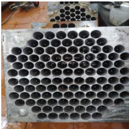
主楼平台净化器清洗后
