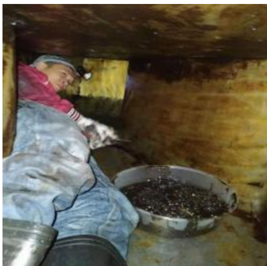
主楼 5 到 4 楼竖管施工中
