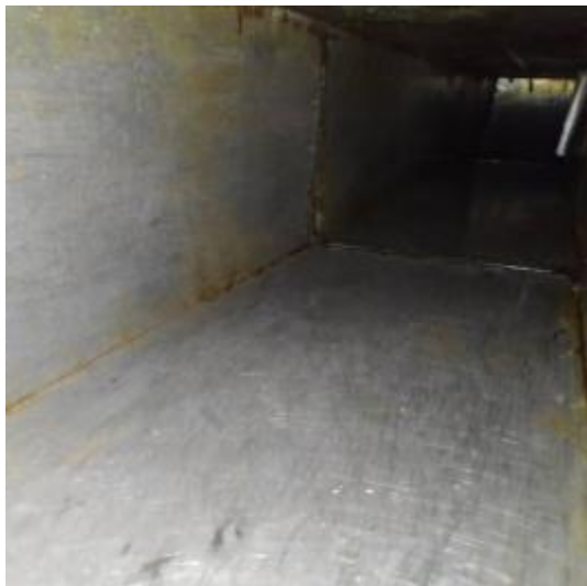
主楼3楼厨房管道清洗后
