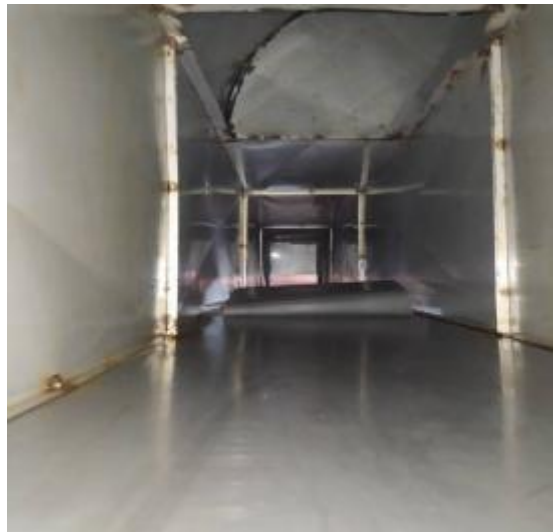
主楼1楼西厨管道清洗后 1
