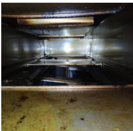
主楼 4 楼厨房管道清洗后 2
