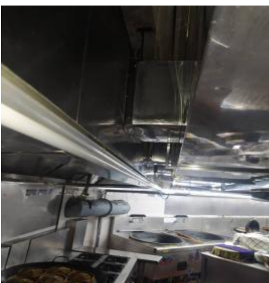
主楼3楼厨房烟罩清洗后 3
