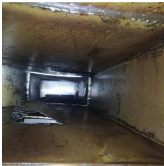
主楼 4 楼厨房管道清洗前 1
