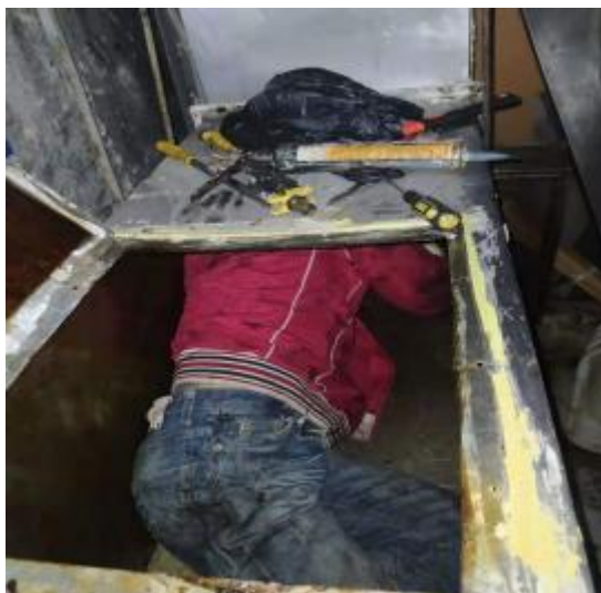
主楼 5 到 4 楼竖管施工中
