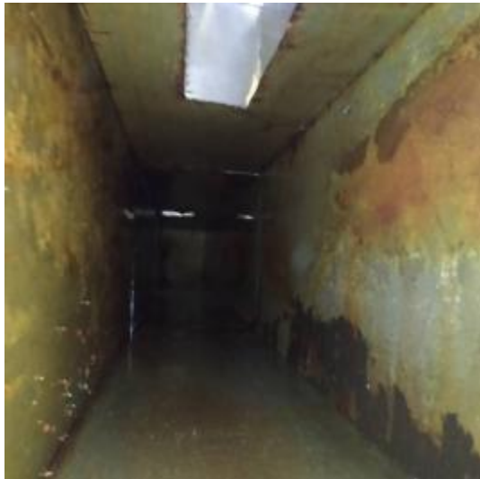
主楼3楼厨房管道清洗前
