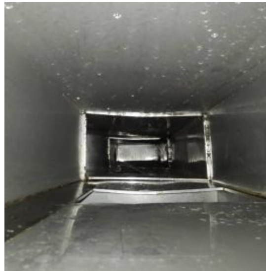
主楼 4 楼厨房管道清洗后 1
