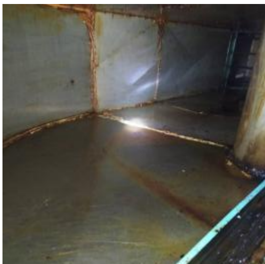
东楼横管道清洗前
