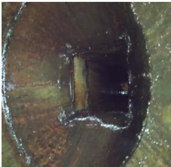
主楼 5 到 4 楼竖管清洗前
