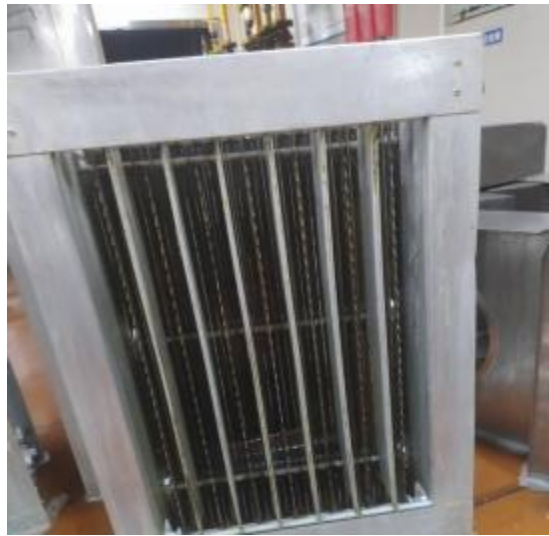
东楼1楼净化器清洗后
