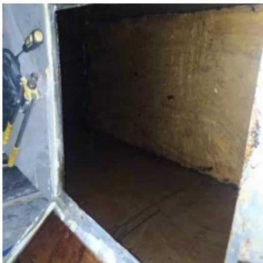
主楼 5 到 4 楼竖管清洗前
