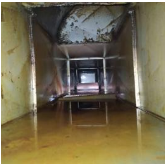
主楼1楼西厨管道清洗前 1
