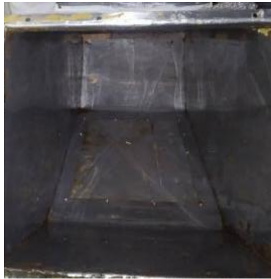
主楼 4 楼库房管道清洗后
