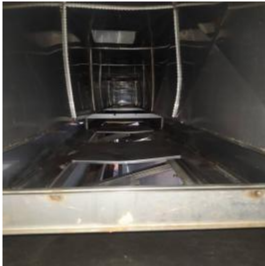
东楼1楼管道清洗前 1
