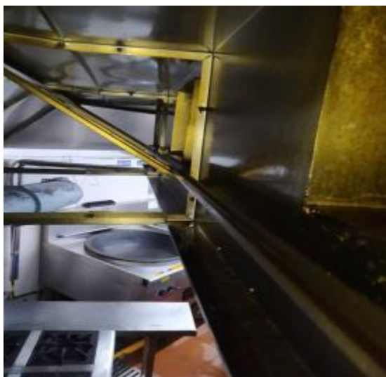
主楼3楼厨房烟罩清洗前 1
