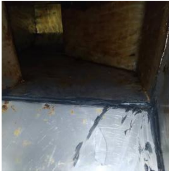
主楼 4 楼库房管道施工中
