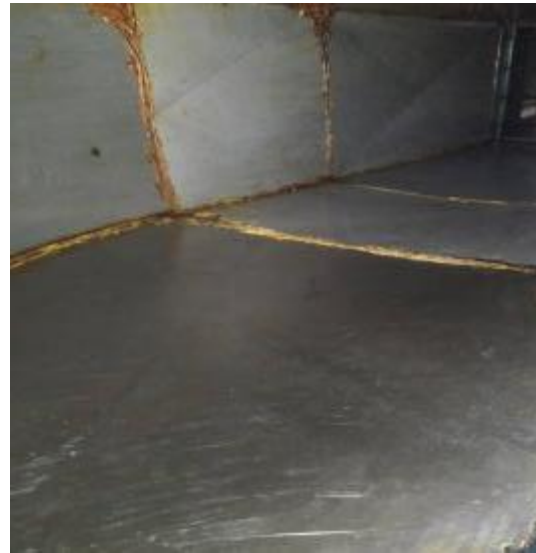
东楼1楼主管道清洗后
