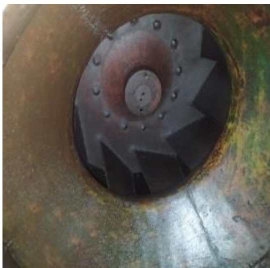
主楼平台风机清洗后 1
