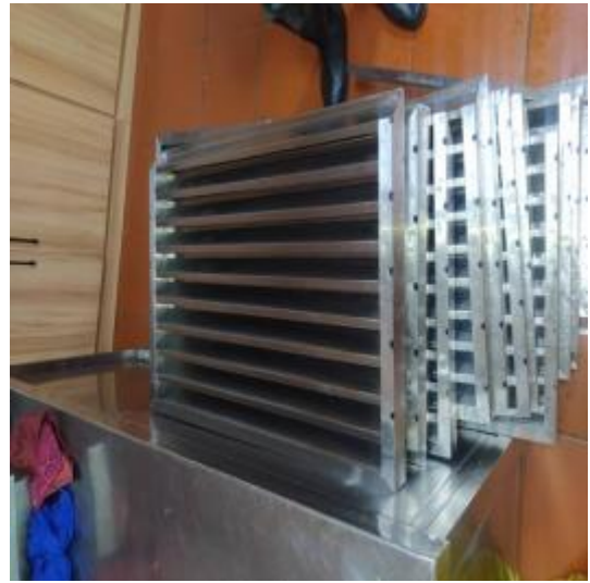
主楼西厨防火板清洗后
