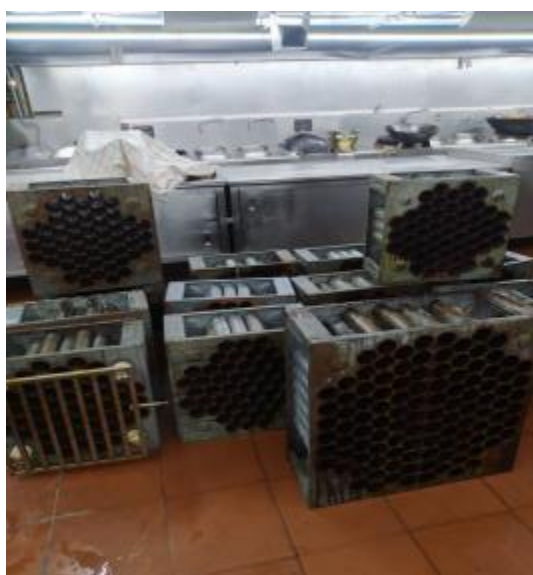
主楼 6 楼平台净化器清洗前
