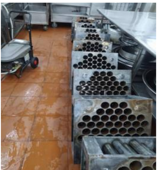
主楼 6 楼平台净化器清洗后
