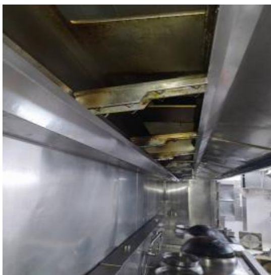
主楼 4 楼厨房烟罩清洗前 1
