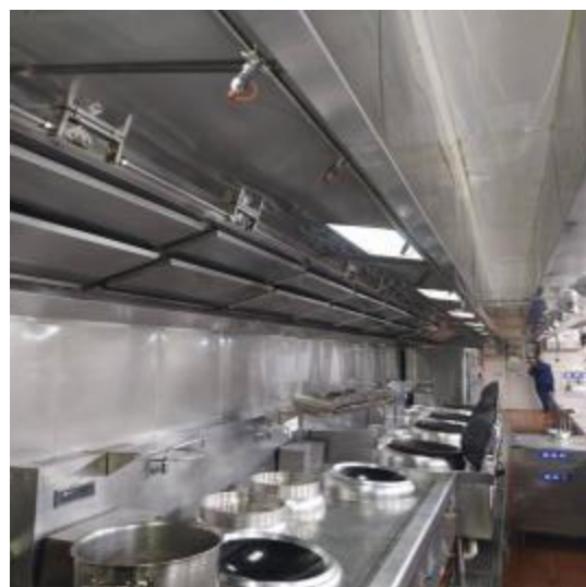
东楼 1 楼烟罩清洗后 2
