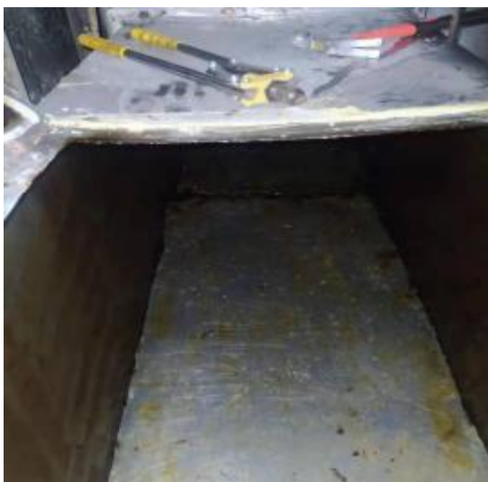
主楼 5 到 4 楼竖管清洗后
