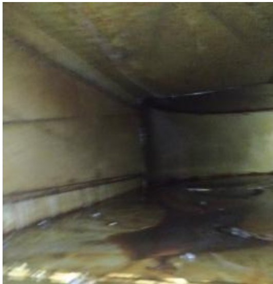
东楼1楼主管道清洗前
