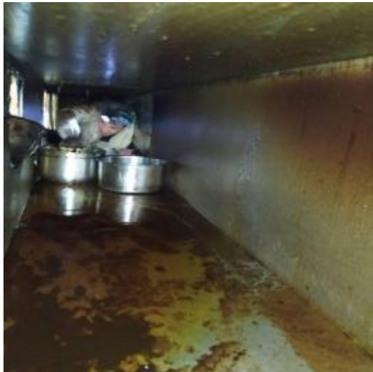
主楼3楼厨房管道施工中
