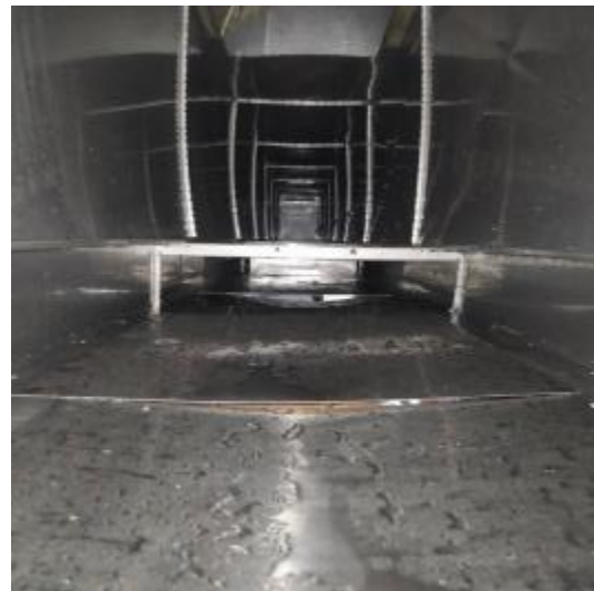
东楼1楼管道清洗后 1
