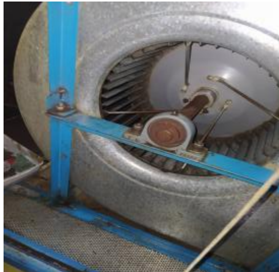
东楼1楼厨房风机清洗后
