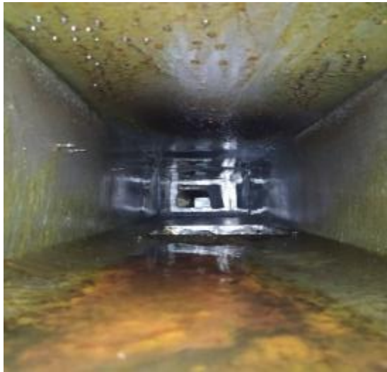
主楼 1 楼西厨管道清洗前 2
