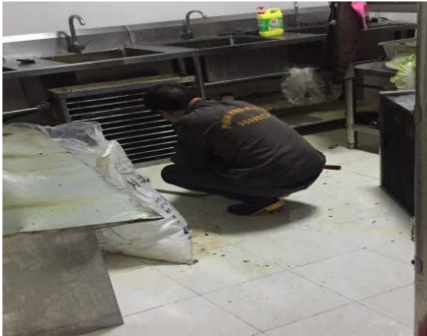
净化器施工中
