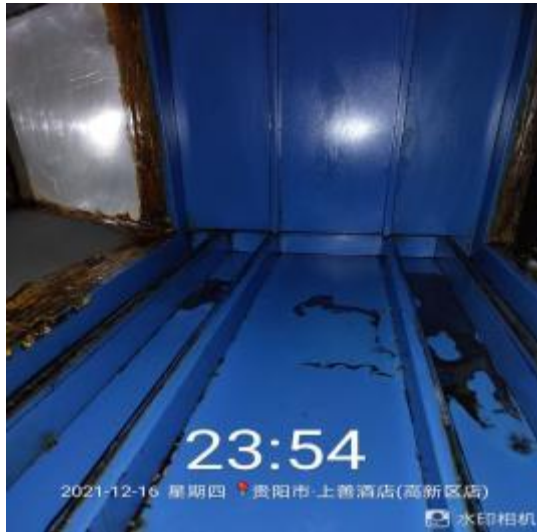
净化器机箱清洗后
