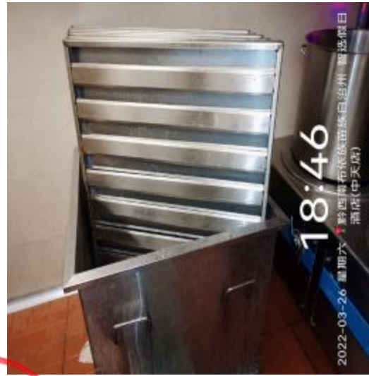
防火板清洗中
