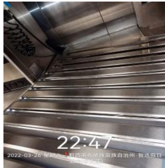
防火板清洗后
