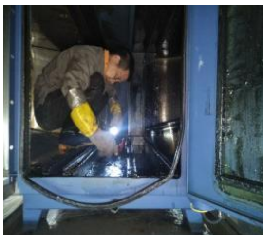
净化器内部施工
