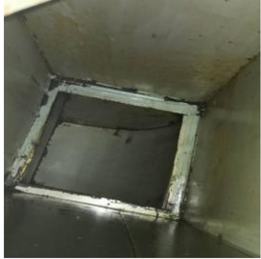
管道内部清洗后
