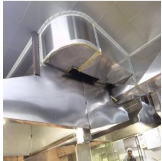
管道外观清洗后
