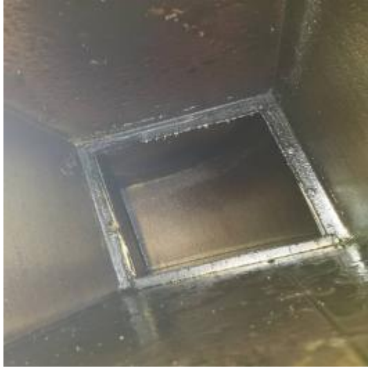
管道清洗内部前
