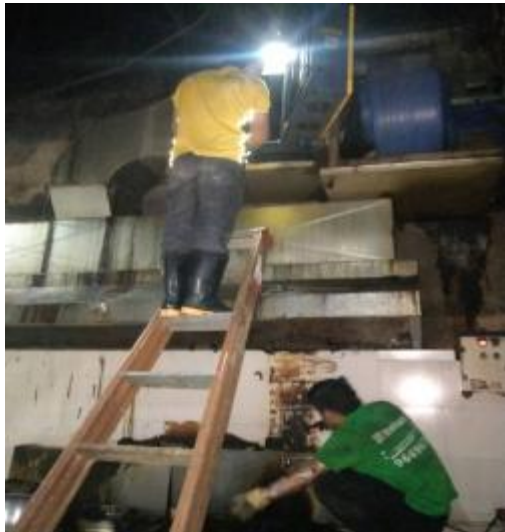
净化器施工中
