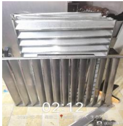
防火板清洗后
