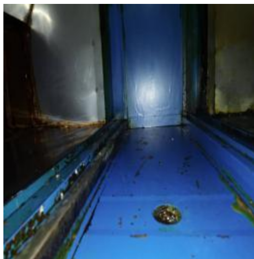
净化器机箱清洗后
