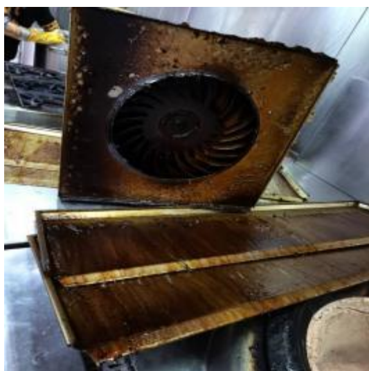
挡油板清洗前
