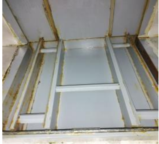
净化器机箱清洗中
