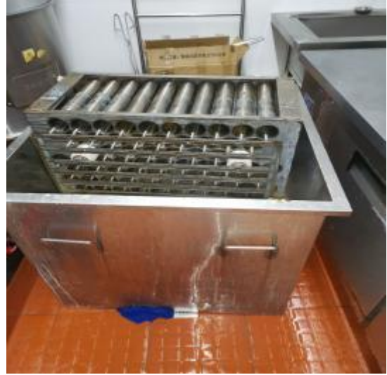
净化器施工中
