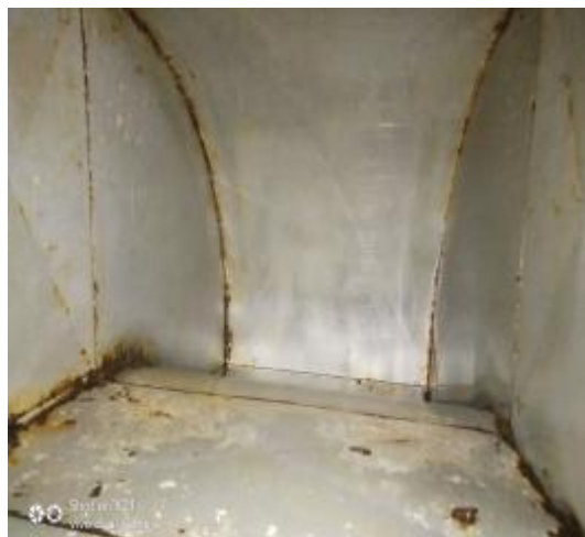
垂直管道清洗后 1
