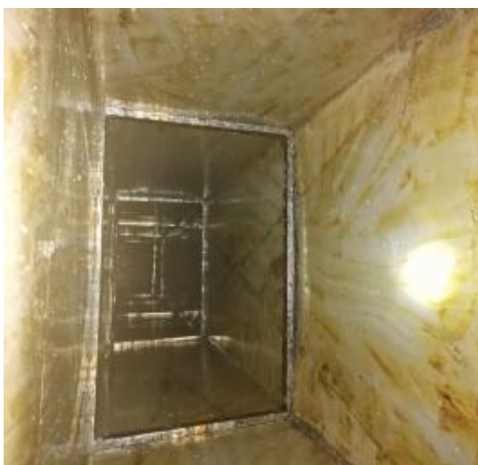
垂直管道清洗后 3
