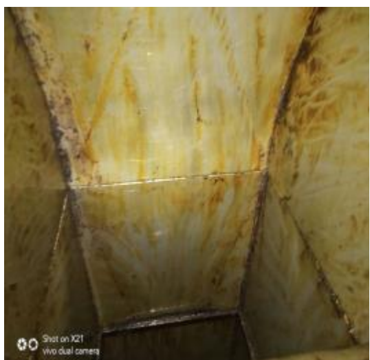
垂直管道清洗前 2
