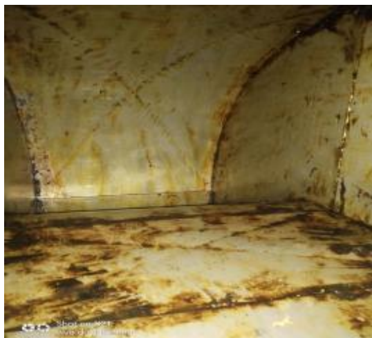
垂直管道清洗前 1
