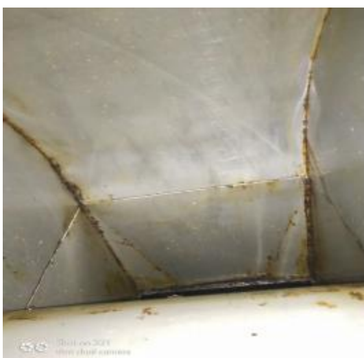
垂直管道清洗后 2
