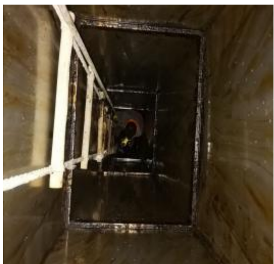
垂直管道清洗前 3
