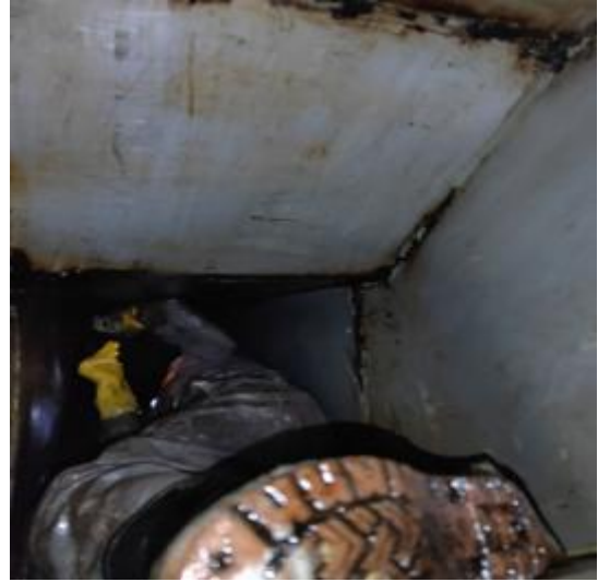
管道内部施工中
