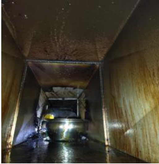
管道内部施工中
