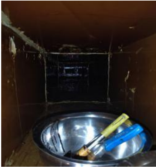
管道内部施工中
