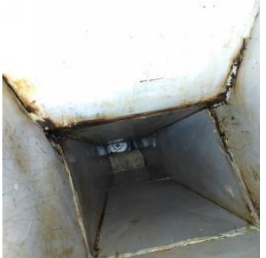
管道风机清洗后 3
