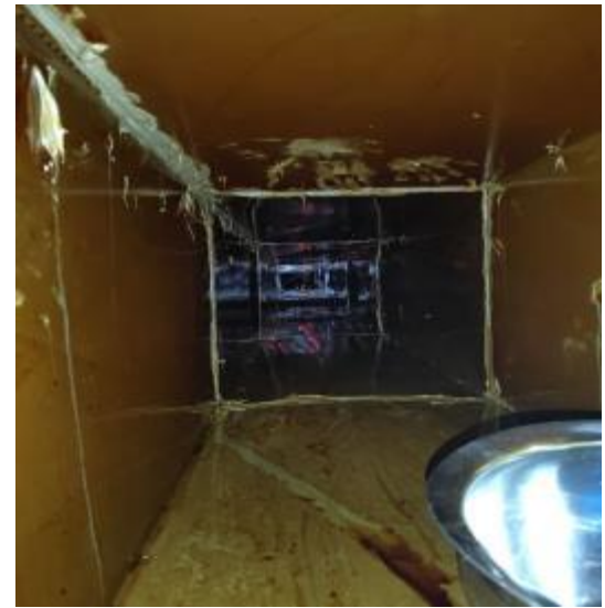
管道内部施工中
