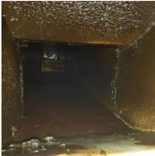
管道风机前清洗前 3
